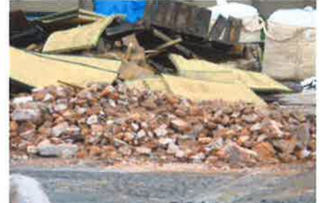
正面の本館側はすでに解体
