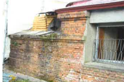
解体作業中のイタリア館
