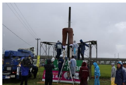
下部・足の部分の設置です
